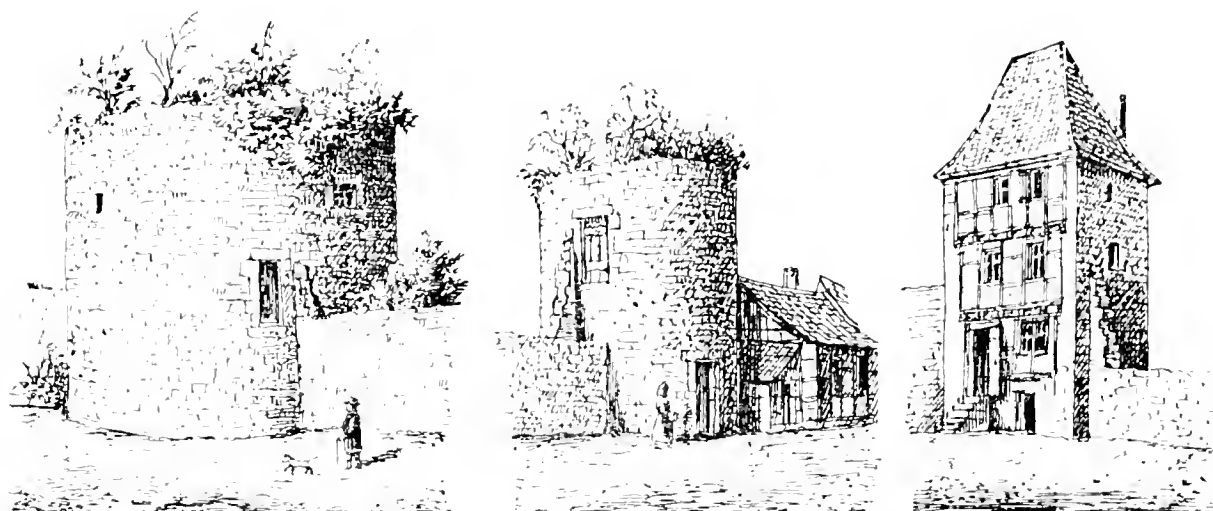
Fig. 73. Ratingen. Türme der Stadtbefestigung.
